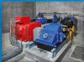
Turbines à impulsion radiale
