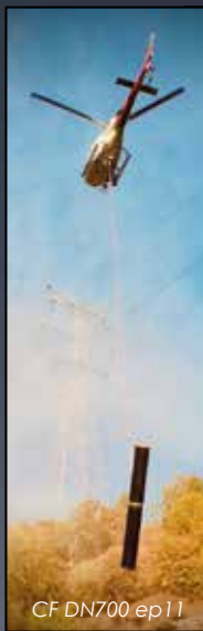
Conduite Forcée DN800 PN30
