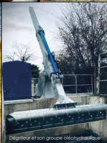
Dégrilleur de 8 mètres de large
