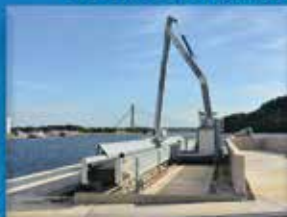
Systèmes de dégrillage
