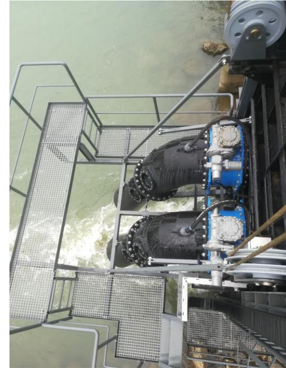
**Contexte :** Turbinage du débit d'un réservoir tampon sur une porte vanne mobile
