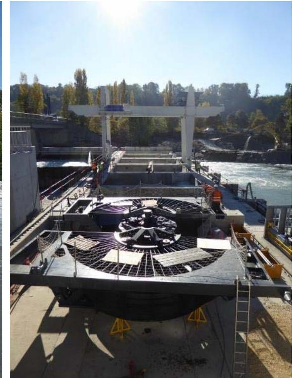
PCH de Chavort Portique pont roulant de 60 T de capacité
